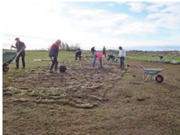
Figur 99. Arbete med att lägga igen det stora schaktet. Foto Marianne Hellberg.
